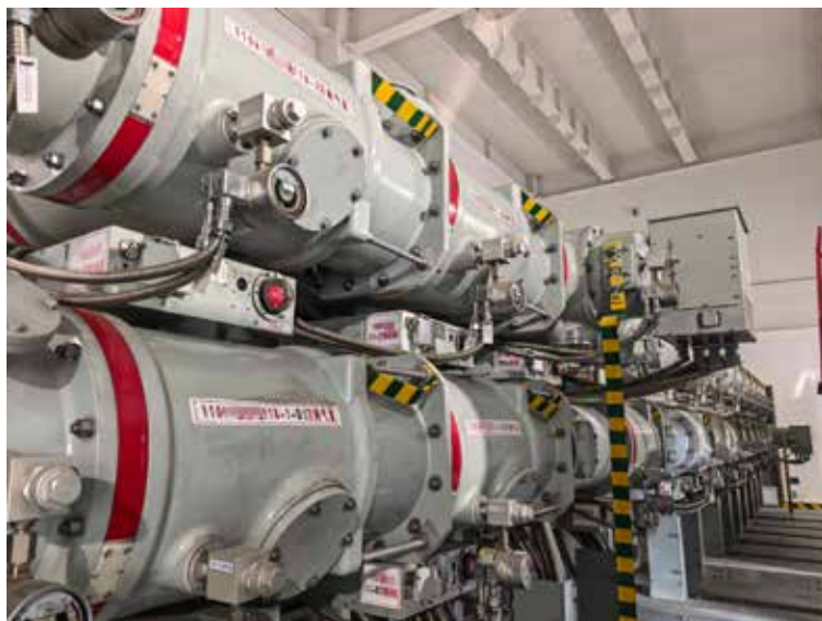
图：一个高压开关室内通常有数十个表计
