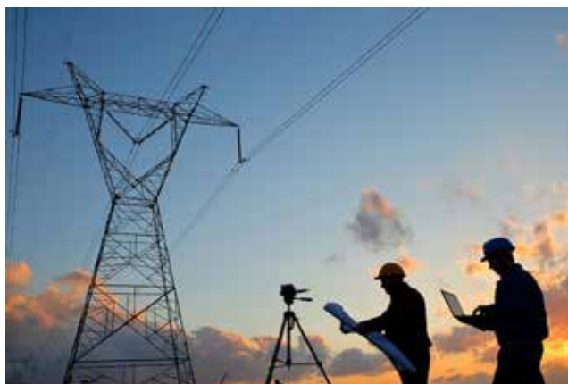
图：输电线路运行安全保障
