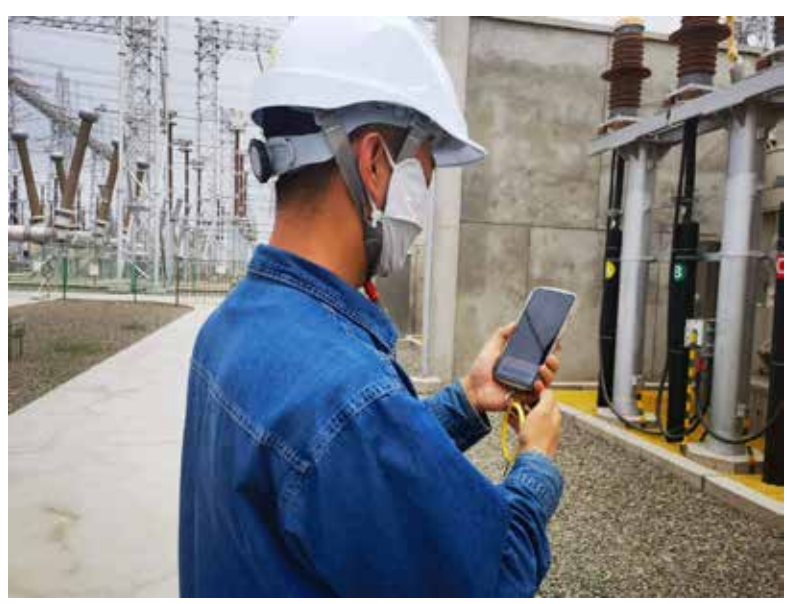
图：超高压分公司员工在750千伏木垒变电站利用远程视频研判站用变运行情况
