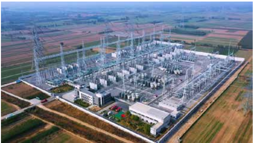
图：已建成的1000KV特高压变电站WAPI应用示范
