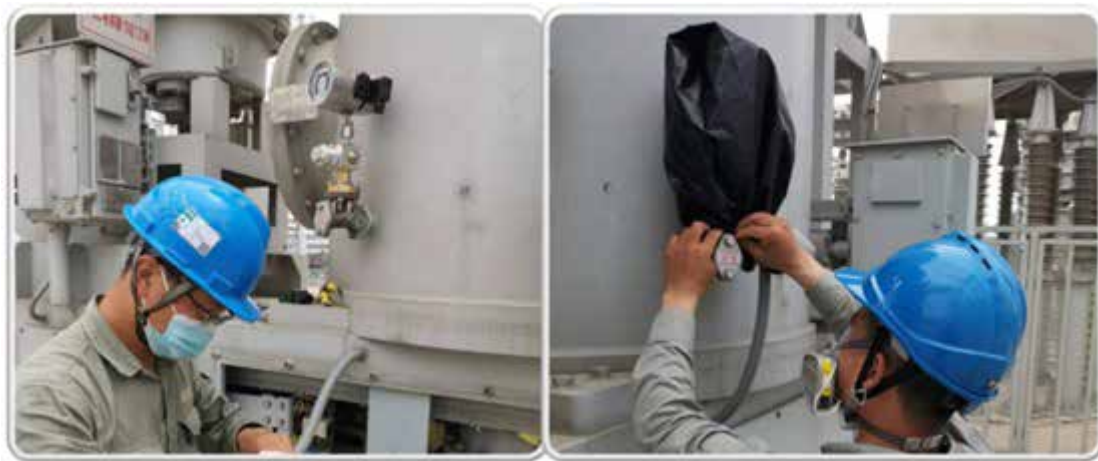
图：SF6数字化密度表现场安装
